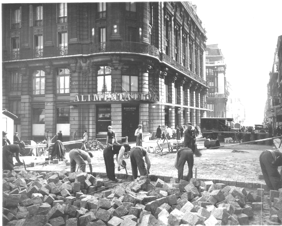
Chantier rue de Clignancourt, derrière les grands magasins Dufayel, vers 1930. Pose de pavage en pierre (Iconothèque de la direction de la Voirie).
