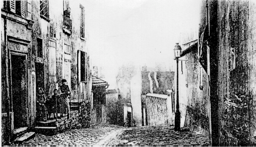
L'impasse Trainée et son égout axial en 1925 avant son ouverture et sa transformation en rue Poulbot. Il s'agit de la dernière modification majeure de tracé dans l'espace "historique" inscrit à l'Inventaire supplémentaire des Monuments historiques en 1949. Son profil en V a servi de modèle historiciste aux opérations futures de simple réfection accomplies dans le "village".
